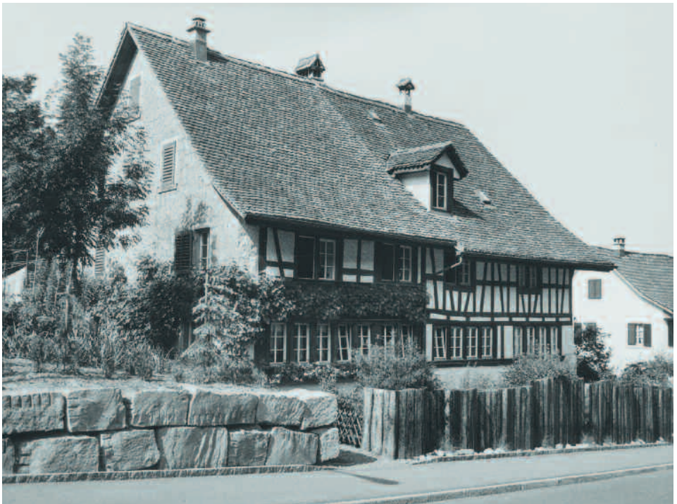
Der obere Hausteil mit den erhaltenen Falläden, 1980.
