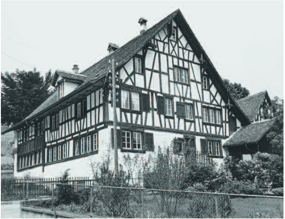
Der untere Hausteil mit Anbau und markanter Eingangstreppe, 1973.
